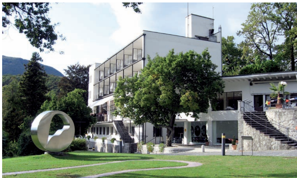
Abgehoben und gedankenerhebend im Bauhaus-Stil: Das Tagungs- und Kongresshotel auf dem Monte Verità
